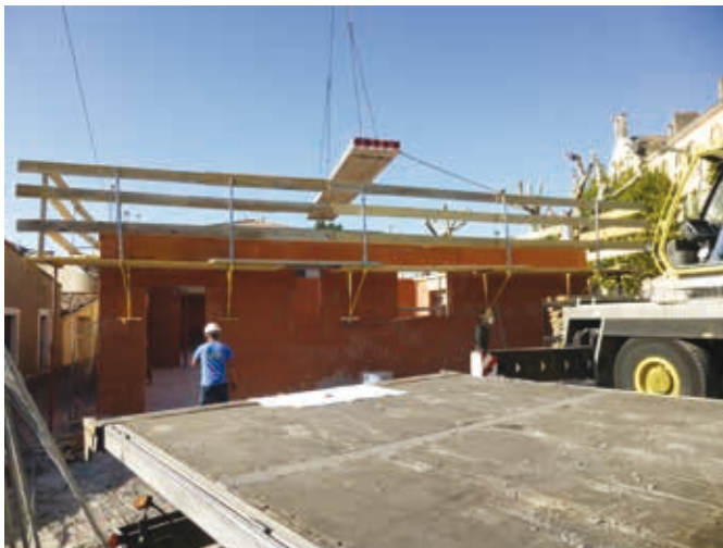
Construction Pôle Santé
