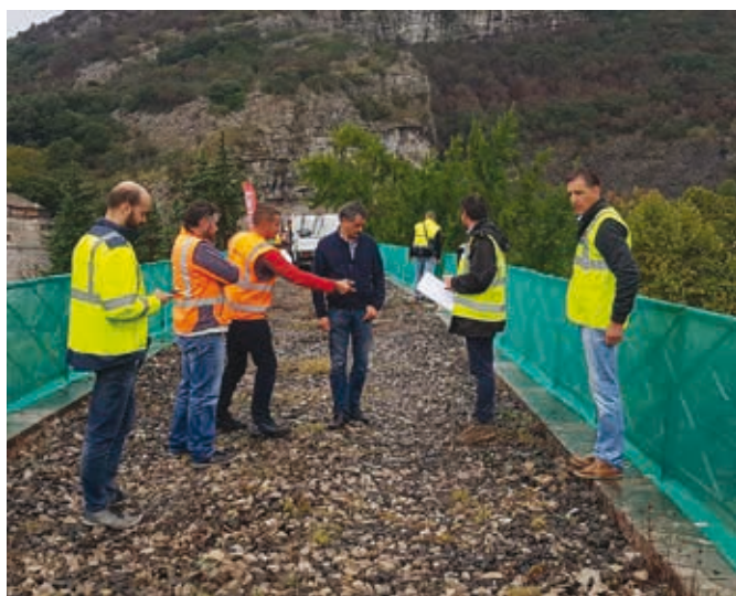
Réunion de chantier sur le Viaduc
