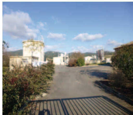
Station d'épuration du Tapis Vert
