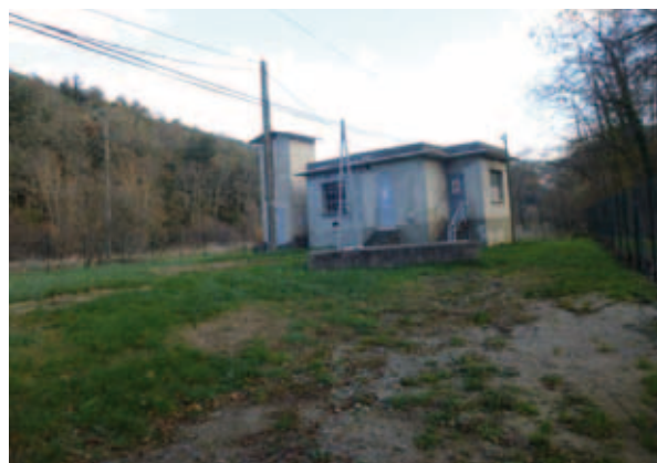
Station de pompage de Baumel
