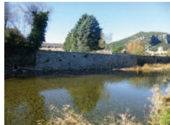
Mur de soutènement du plateau sportif mitoyen au Vidourle
