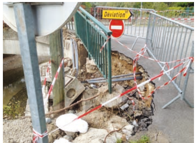
Travaux de mise en sécurité des réseaux
