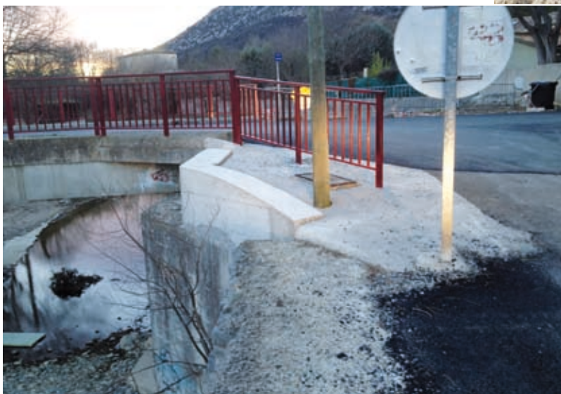
Consolidation de la voirie après les inondations, chemin de l'Argentesse
